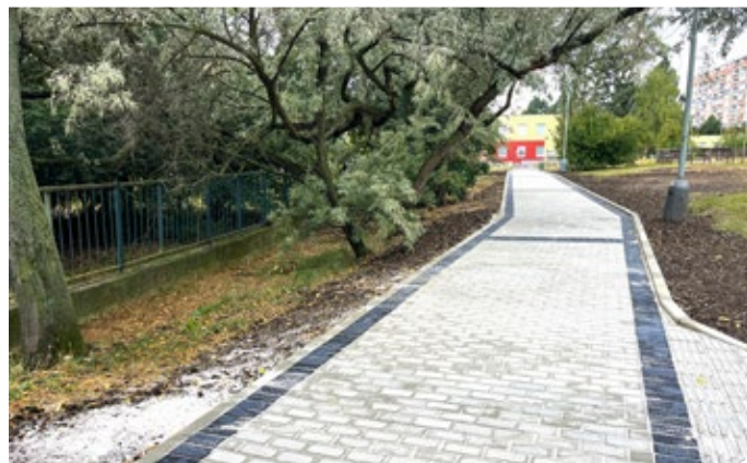
Zámková dlažba je nově na chodníku mezi ulicemi Drahoňovského a Socháňova.
